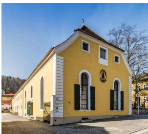
Die Unternehmenszentrale in der ehemaligen Schlossbrauerei Etterzhausen (Foto: Chips 4 Light GmbH)
