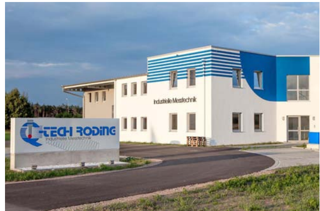
Ein Meilenstein in der Q-Tech-Geschichte: der Umzug in das eigene Firmengebäude im Jahr 2012. (Quelle: Q-Tech Roding)
